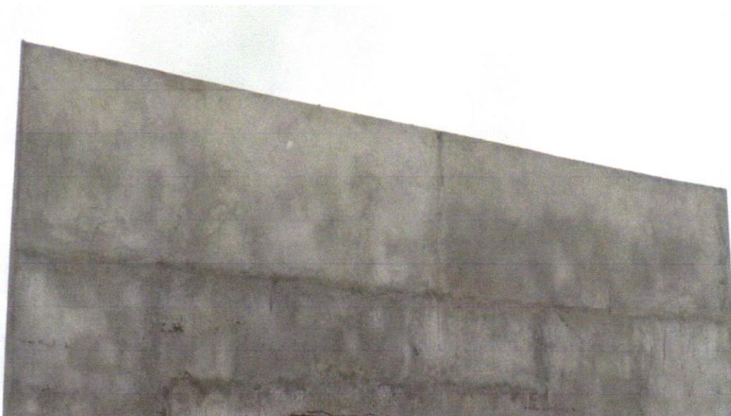
FOTO03- MASSA ÚNICA, PARA RECEBIMENTO DE PINTURA, EM ARGAMASSA TRAÇO 1:2:8, PREPARO MANUAL, APLICADA MANUALMENTE EM FACES INTERNAS DE PAREDES, ESPESSURA DE 10MM, COM EXECUÇÃO DE TALISCAS. AF_06/2014
