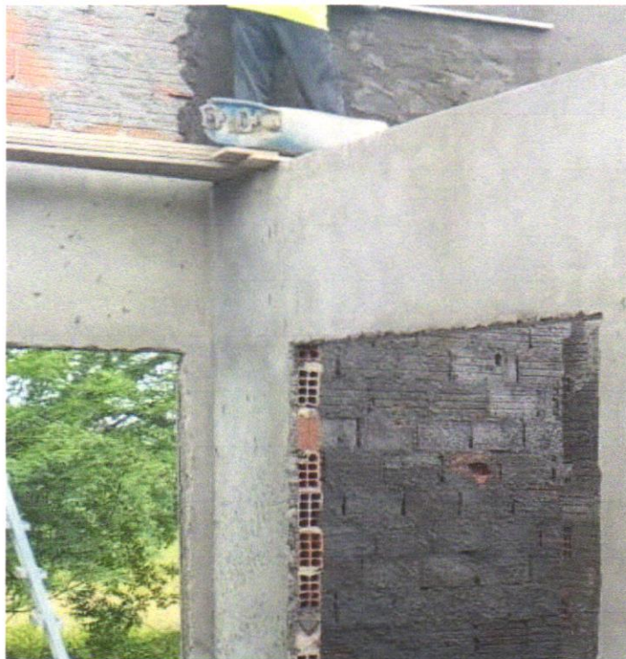
FOTO 05—CHAPISCO APLICADO EM ALVENARIAS E ESTRUTURAS DE CONCRETO INTERNAS, COM COLHER DE PEDREIRO. ARGAMASSA TRAÇO 1:3 COM PREPARO EM BETONEIRA 400L. AF_06/2014
