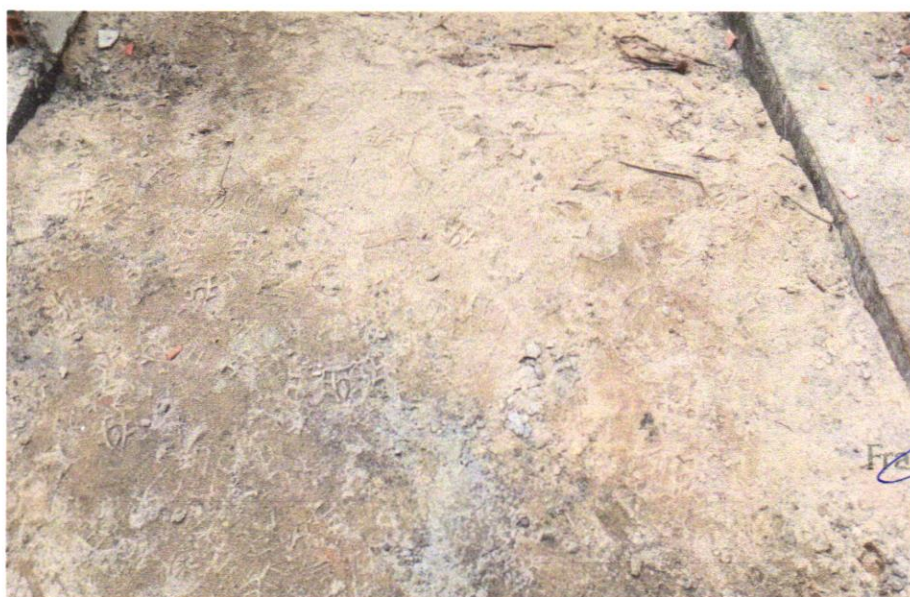
FOTO 05—CHAPISCO APLICADO EM ALVENARIAS E ESTRUTURAS DE CONCRETO INTERNAS, COM COLHER DE PEDREIRO. ARGAMASSA TRAÇO 1:3 COM PREPARO EM BETONEIRA 400L. AF_06/2014
