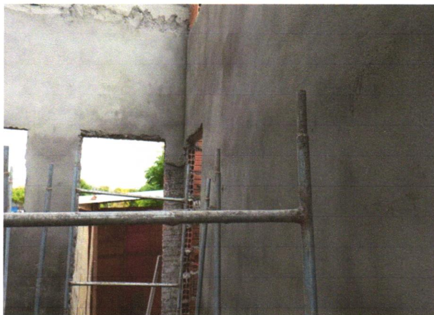
FOTO 01 – MASSA ÚNICA, PARA RECEBIMENTO DE PINTURA, EM ARGAMASSA TRAÇO 1:2:8, PREPARO MANUAL, APLICADA MANUALMENTE EM FACES INTERNAS DE PAREDES, ESPESSURA DE 10MM, COM EXECUÇÃO DE TALISCAS. AF_06/2014
